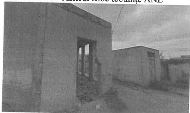
Vecinătate- fosta centrală termică
